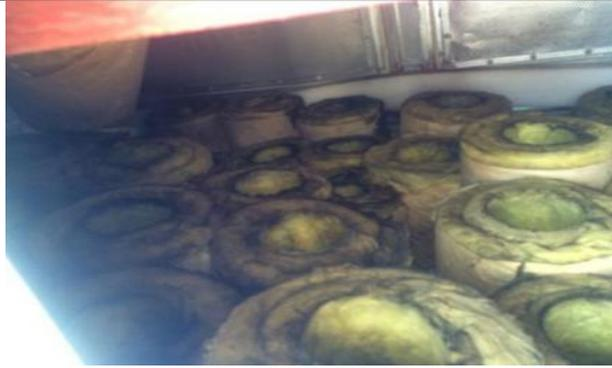
1. 辽河路校区食堂风机净化机组共 32 组，每套机组内含吸油棉 80 根，合同期内风机吸油棉需更换一次，2022 年 7 月进行。
