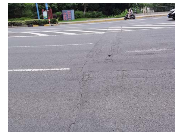
横缝、龟裂、坑槽
