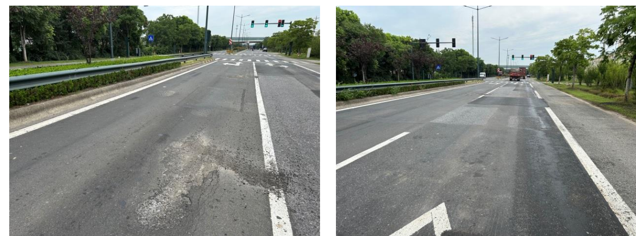
前黄大桥匝道交叉口 K7+360~K7+400 (上行 1 车道)
