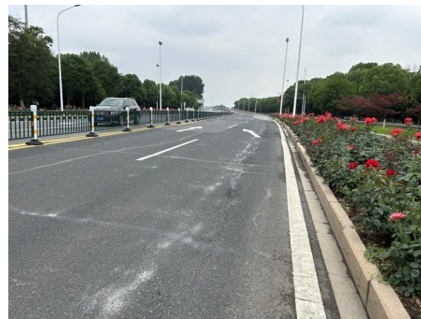
路面横纵向裂缝伴随沉陷、龟裂、拥包
