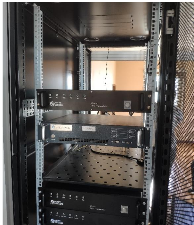
图 4-7 增强型 AIS 基站室内安装示意图
