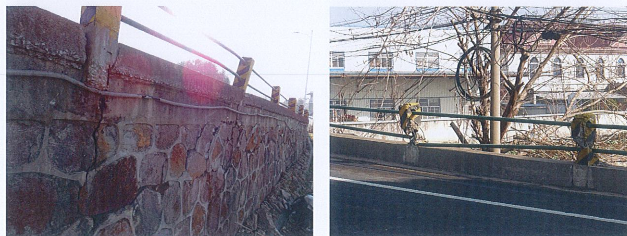
图 3.3 南侧引道栏杆
