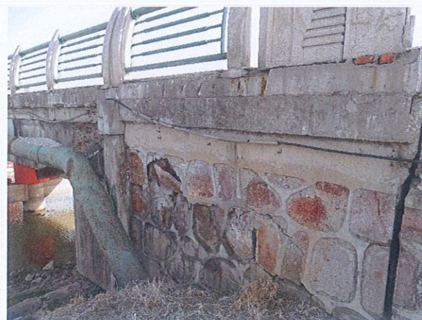
图 3.5 西南侧桥台侧墙
