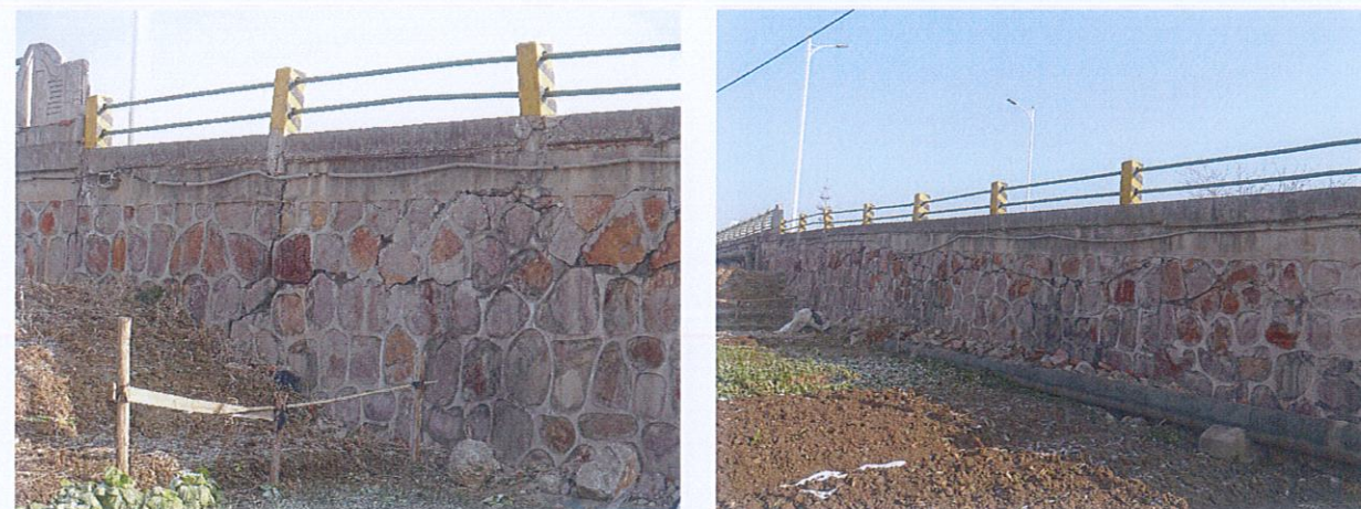
图 3.1 西南侧引道挡墙
