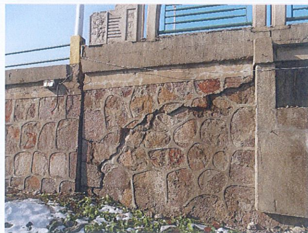
图 3.4 东南侧桥台侧墙
