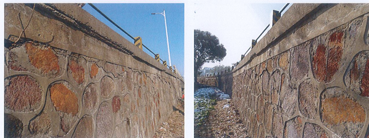
图 3.2 东南侧引道挡墙
