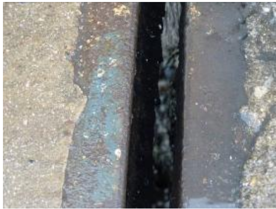
图 5.18 伸缩缝橡胶条破损
