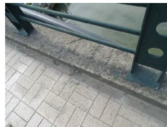
图 5.33 栏杆基座抹面露筋
