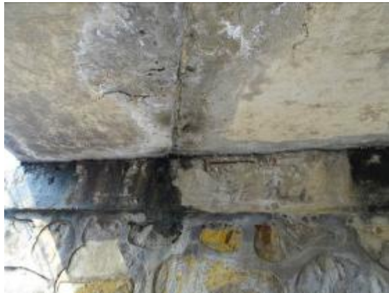
图 5.10 两侧通道台帽、板底、挑臂、中分带盖板多处砼剥落钢筋锈胀
