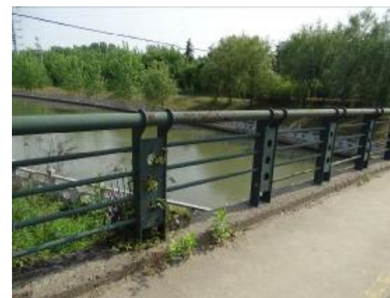
图 5.32 栏杆钢管缺失、锈蚀、掉漆
