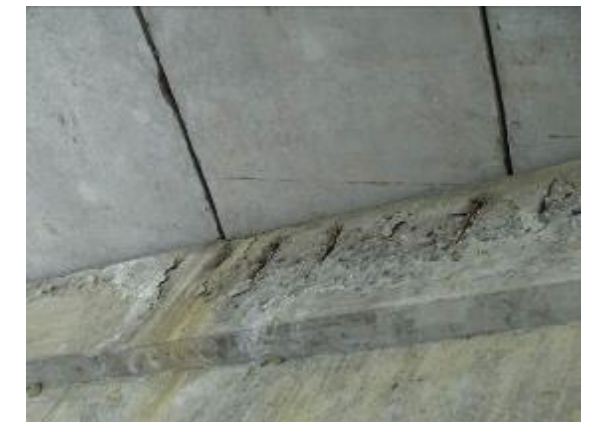
图 5.25 台帽钢筋锈胀
