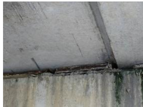
图 5.1 支座环向开裂、钢板锈蚀严重
