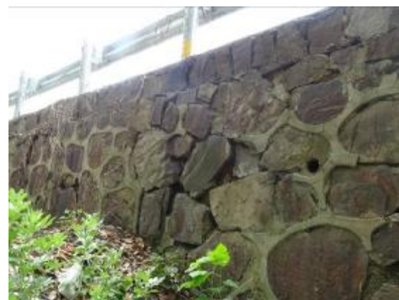
图 5.2 桥台浆砌块石挡墙局部开裂、脱空
