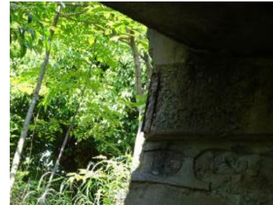
图 5.23 台帽钢筋锈胀
