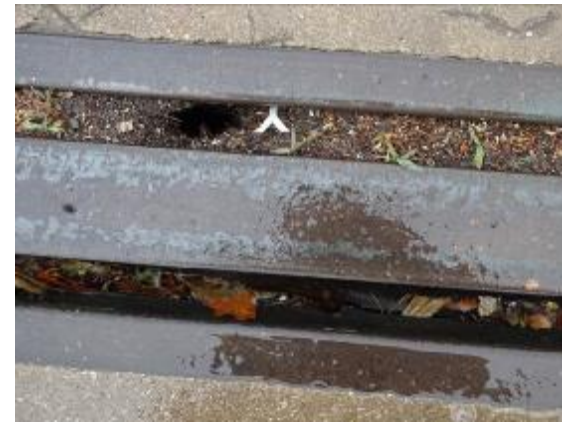
图 5.18 伸缩缝橡胶条破损
