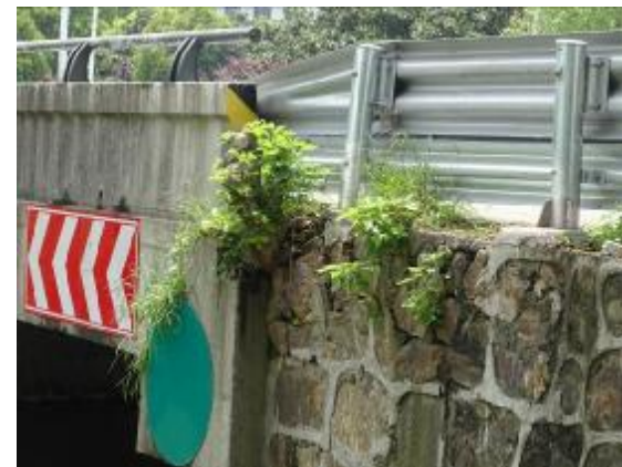
图 5.20 东北侧桥台存在树木生根
