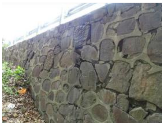
图 5.2 桥台浆砌块石挡墙局部开裂、脱空
