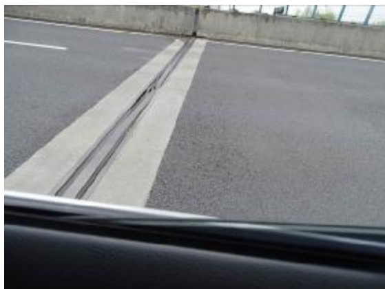
图 5.13 伸缩缝型钢断裂、橡胶条破损
