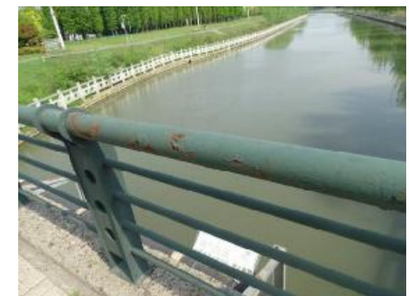
图 5.32 栏杆钢管缺失、锈蚀、掉漆
