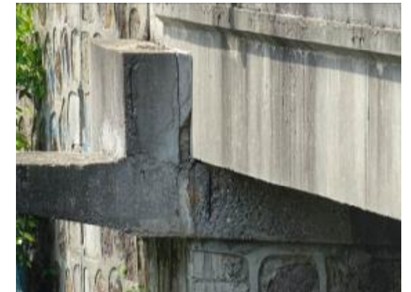
图 5.15 台帽、挑臂钢筋锈胀
