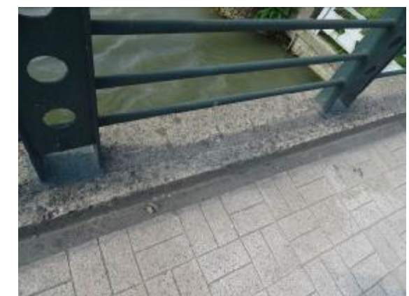
图 5.33 栏杆基座抹面露筋
