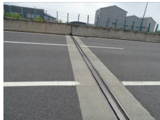
图 5.13 伸缩缝型钢断裂、橡胶条破损
