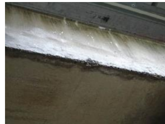
图 5.17 板梁底、盖梁局部砼剥落露筋
