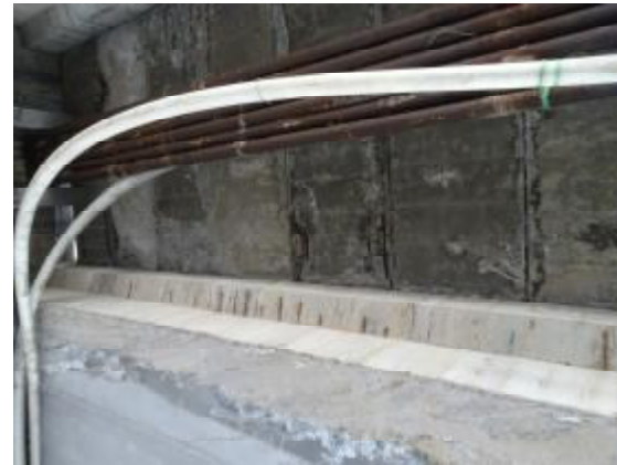
图 5.10 两侧通道台帽、板底、挑臂、中分带盖板多处砼剥落钢筋锈胀
