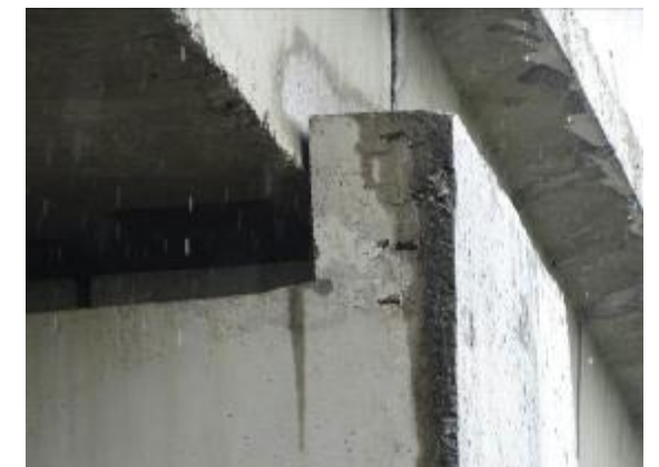
图 5.17 板梁底、盖梁局部砼剥落露筋
