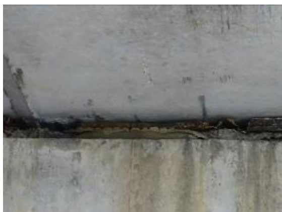
图 5.1 支座环向开裂、钢板锈蚀严重
