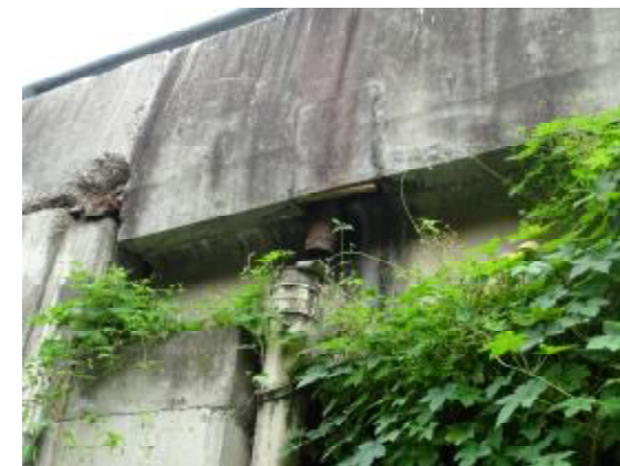
图 5.9 泄水孔脱落
