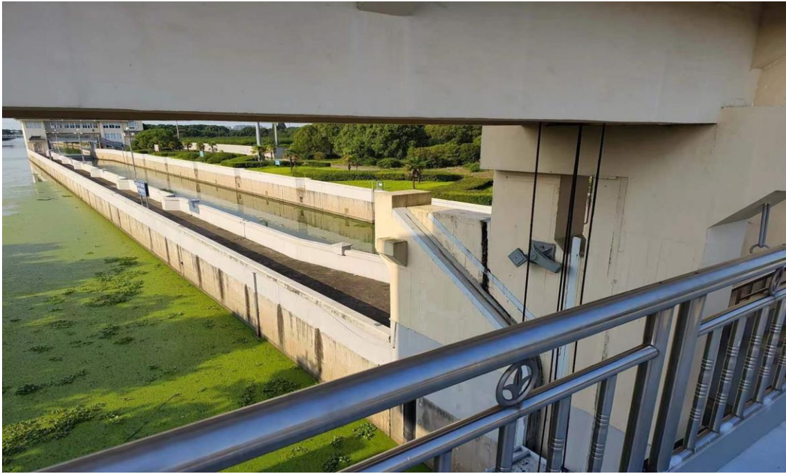
图 1.3-15 雅浦港枢纽上闸首启闭机房排架外墙现状 1
