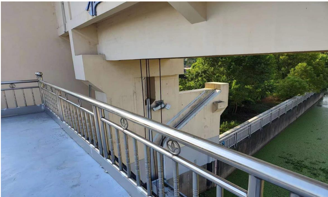
图 1.3-16 雅浦港枢纽上闸首启闭机房排架外墙现状 2
