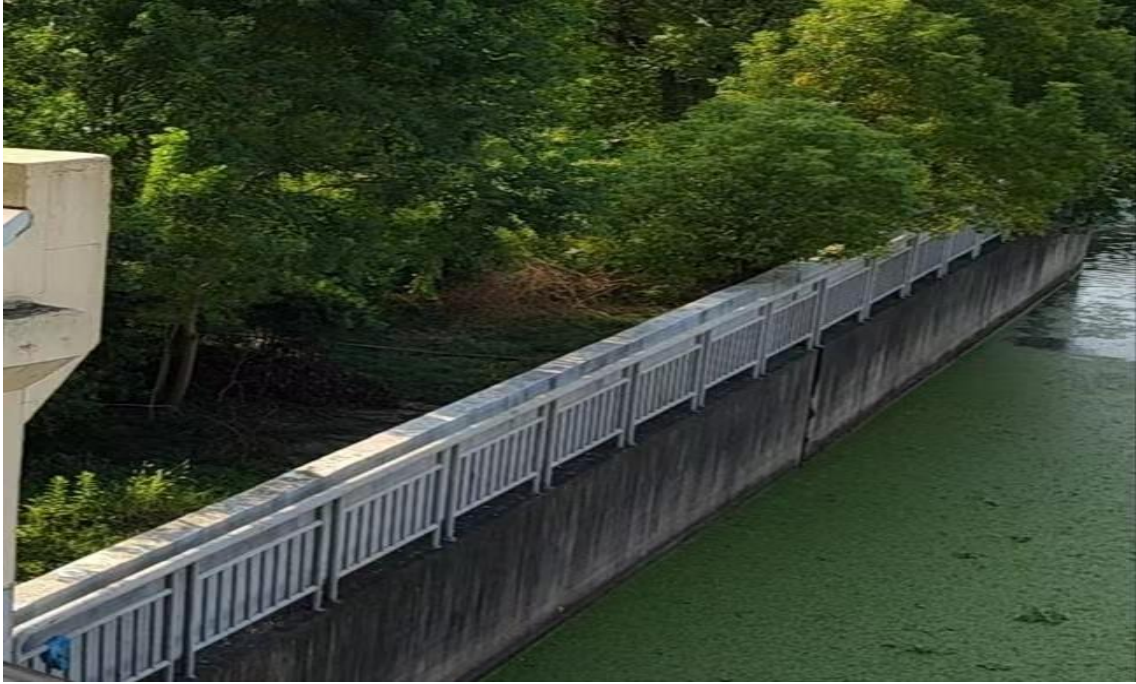
图 1.3-12 雅浦港枢纽节制闸侧翼墙现状
