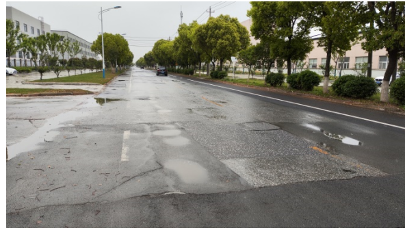
修补不良、沉陷
