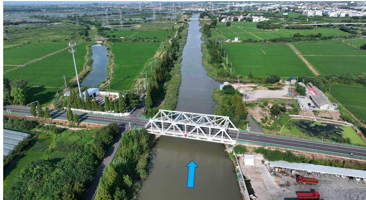
图 1-2 本次疏浚起点现状照片
