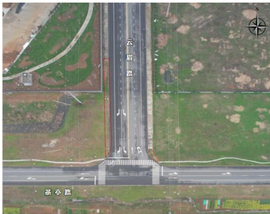
云眉路与茶亭路交叉口现状
