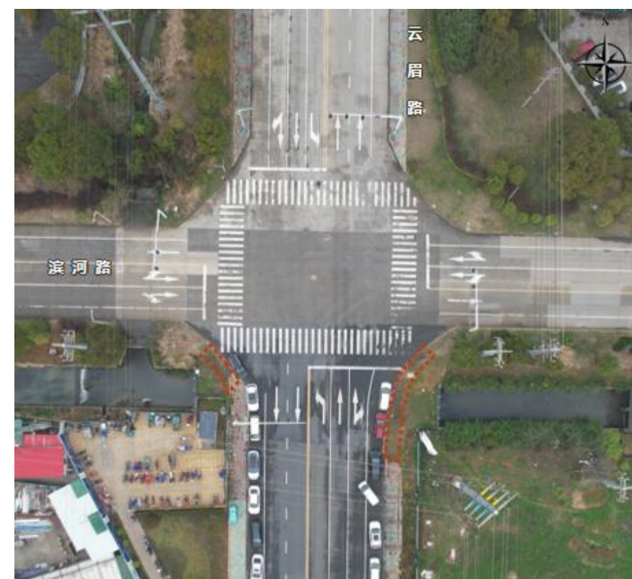
云眉路与滨河路交叉口现状
